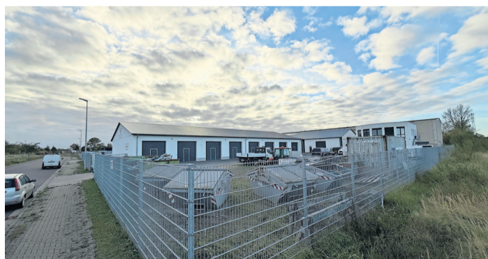
Der Landkreis Vorpommern-Greifswald will in der Wilhelm-Holtz-Straße 24 eine Immobilie für den Rettungsdienst erwerben.
